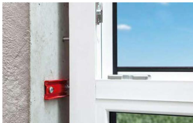
Große, bodentiefe Fensterelemente werden oft ohne zusätzliches Geländer ausgeführt. Die Aufgabe, den Absturz zu verhindern, fällt hier dem Fenster selbst zu. Neben dem Fenster, muss auch die Verankerung am Bauwerk nachweisbar gegen Absturz sichern. Es sind geregelte Bauprodukte oder Bauprodukte mit allgemeinem Verwendbarkeitsnachweis einzusetzen.
